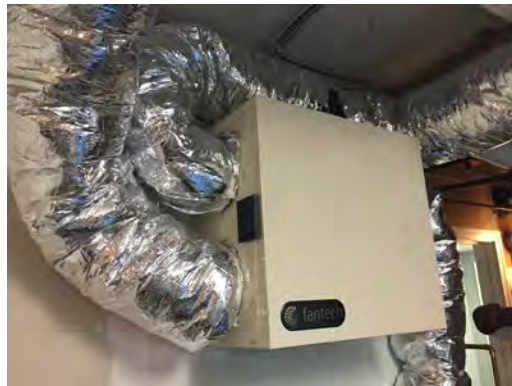
Combustion Air Fan
